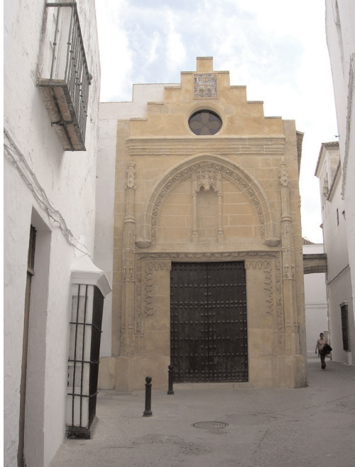
9807412 Iglesia San Antonio Abad. Calle San Antonio Abad 12
